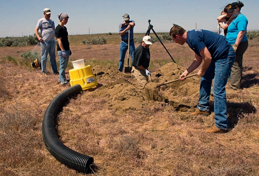
En ny reirhule graves ned. Inngangsrøret er et ca. 3 meter langt drensør av plast, hvor sand dyttes inn langs bunnen når det hele er gravd ned.
